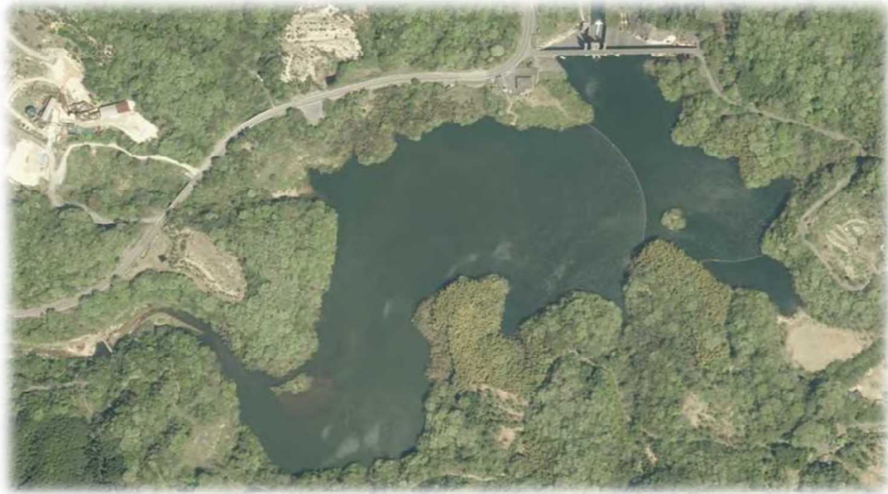
写真-1 H29.4航空写真 ～現況～
