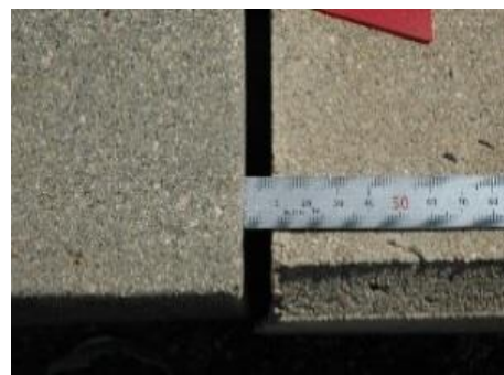
▼犬走りコンクリート隙間の計測
