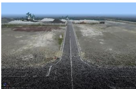
▼写真測量により取得した点群データ 点群から図面が作成可能です。
