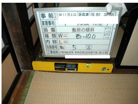
▼敷居傾斜の測定
