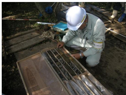
▼調査ボーリング
