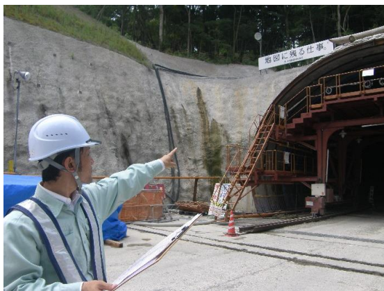
▼施工状況の確認の様子
