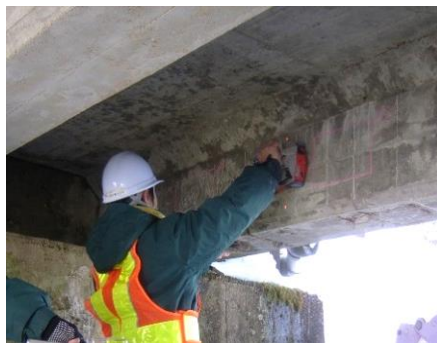
▼鉄筋探査
